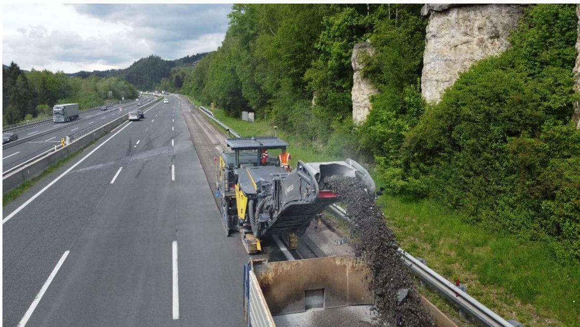
In Kärnten wird ein sechs Kilometer langes Teilstück der A2, im Bereich Wolfsberg-Nord bis zum Gräberntunnel saniert. Die Salzburger Firma ABF setzt dazu das Topcon Smooth Ride System ein, welches sie beim Baumaschinenhändler Kuhn erworben hat.
